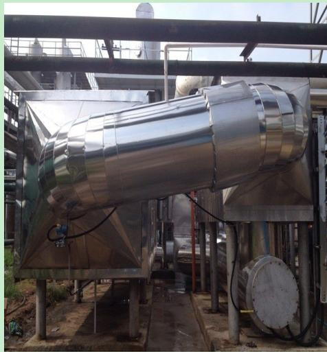
图中 NO<sub>x</sub> 尾气处理系统是为某医药公司设计制造的。该公司有两条氧化制草酸生产线，生产过程中会产生氮氧化物气体污染物。来自工艺尾气 (8000Nm<sub>3</sub>/h, 30℃) 经与 SCR 反应器排净烟气换热后，升温约 90℃ 进入电加热器再一次升温到 180℃，进入 SCR 催化反应器。在 SCR 催化反应器中被选择性还原为 N<sub>2</sub> 和 H<sub>2</sub>O，反应后气体与原废气进行换热后，通过烟囱排放到大气。
